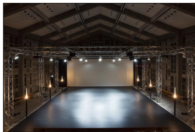
Verbindung von denkmalgeschützter Architektur und modernem Bühnenbetrieb. Denkmalgeschützte Elemente wie die feste Seitenbeleuchtung wurden in den Umbau integriert. © Fulbert Hauk
